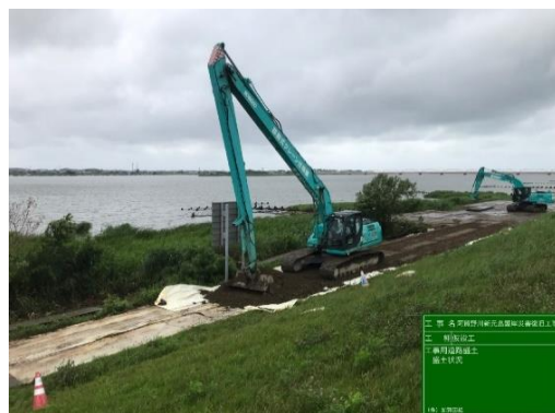
図-12 工事用道路 ICT施工
