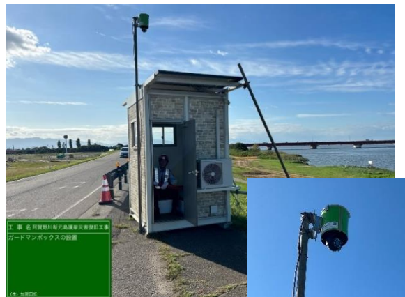
図-4 ガードマンBOX・監視カメラ
