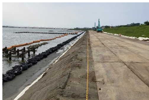
図-12 作業ヤード完成
