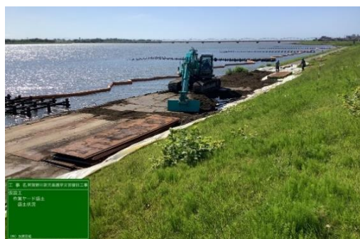
図-13 作業ヤード ICT施工
