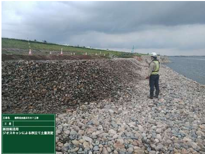
写真 1. 石材検尺状況
