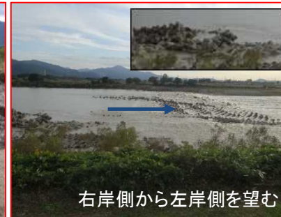
③29.4k渡場床固 床固流出
