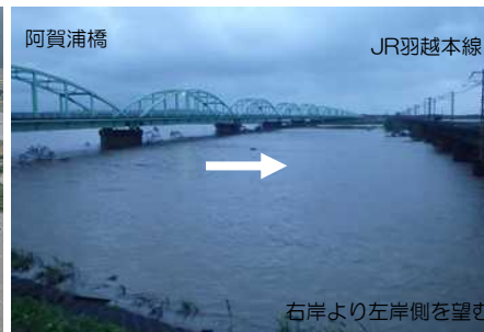
10月13日10時頃撮影 阿賀浦橋・JR羽越線橋りょう
