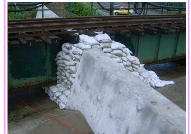
土のう設置による水防活動
