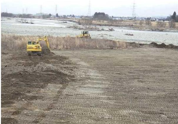
樹木伐採後に、ブルドーザ等による押土・攪拌をすることで、樹木の再繁茂を抑制、コスト縮減を図っている。
