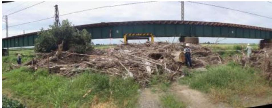
写真 3.48 JR 羽越本線阿賀野川橋梁への流木の堆積状況（平成 23 年 7 月出水）
