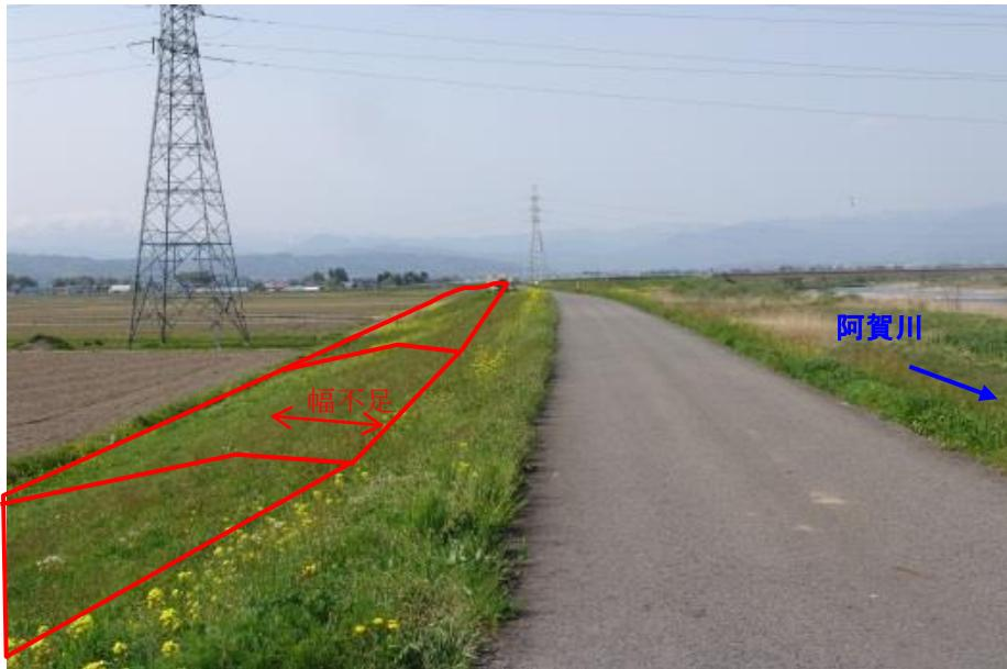
写真 3.27 堤防幅が不足している区間（宮古地区 阿賀川左岸 11.4k の状況）
