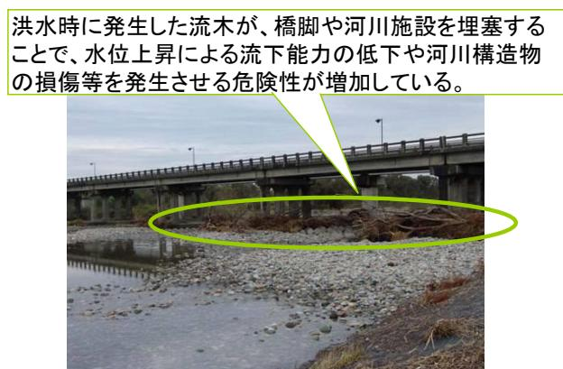
写真 3.46 洪水に伴う流木の橋脚への堆積状況
