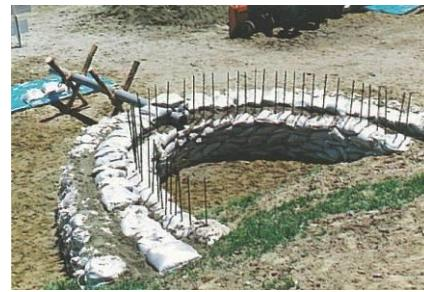
写真 5.41 月の輪工
