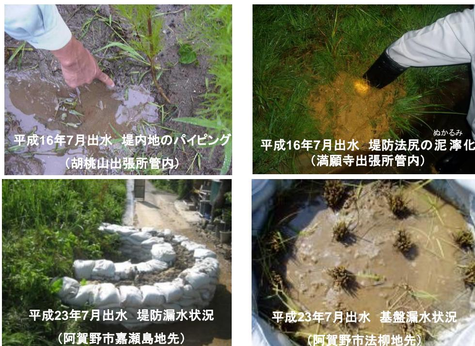
写真 3.33 既往洪水における堤防の被害
