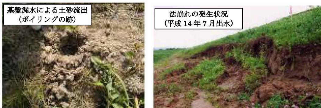
写真 3.32 既往洪水における堤防の被害
