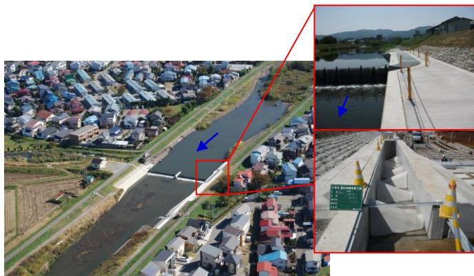
写真 3.71 湯川可動堰に設置された魚道
