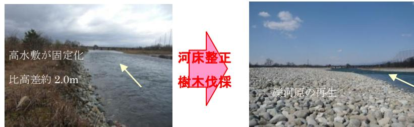
写真 5.10 磯河原の再生状況（上米塚地区 24.4k 付近）
