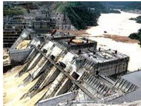
写真 3.5 建設中の大川ダム
