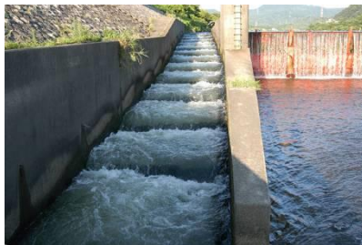
右岸に設置された魚道
