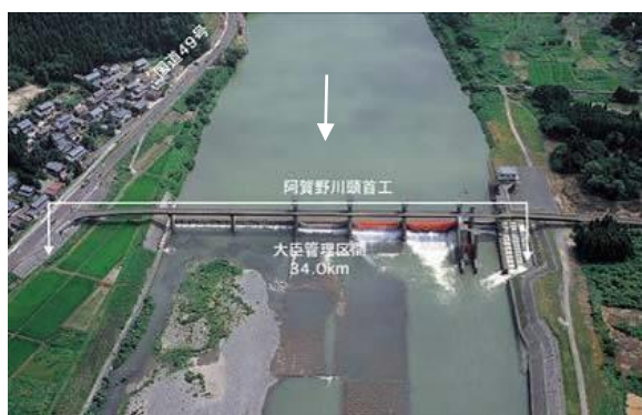
写真 3.60 阿賀野川頭首工
