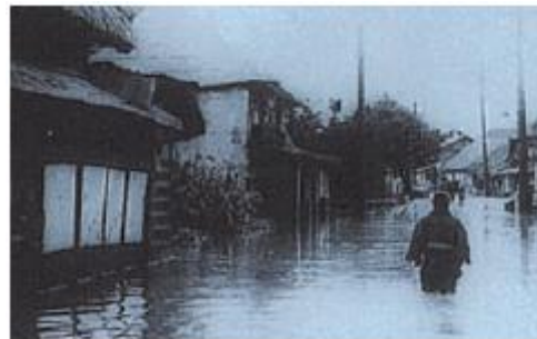
写真 3.15 昭和16年日橋川洪水により冠水した塩川町
