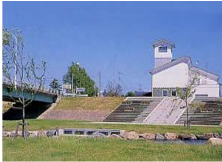
写真 3.14 身神川排水機場
