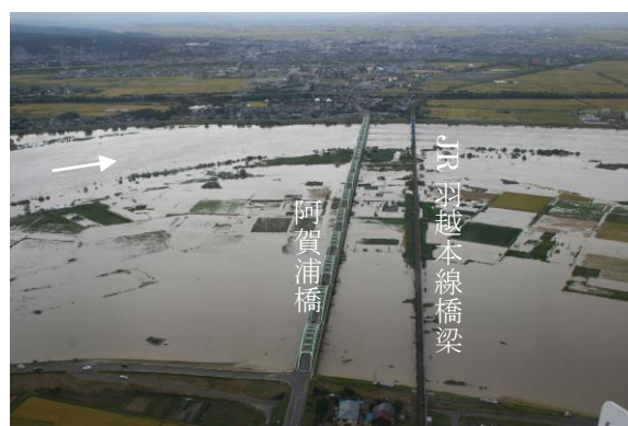
阿賀浦橋、J R 羽越本線橋梁の出水状況
