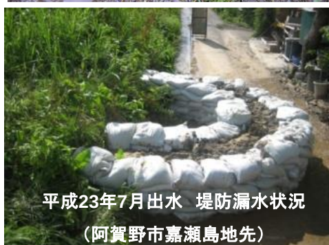
写真 3.33 既往洪水における堤防の被害
