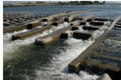
沢海第一床固に設置された魚道
