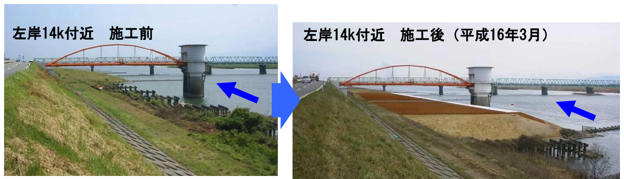
左岸 14k 付近低水護岸 施工前
