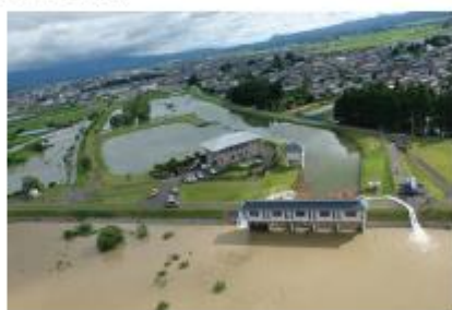
太田川排水機場排水状況
