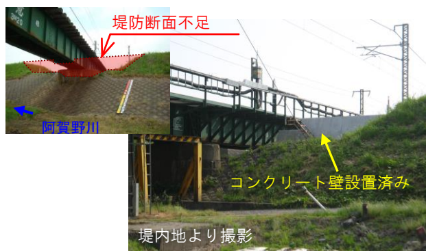
切欠き部へのコンクリート壁設置
