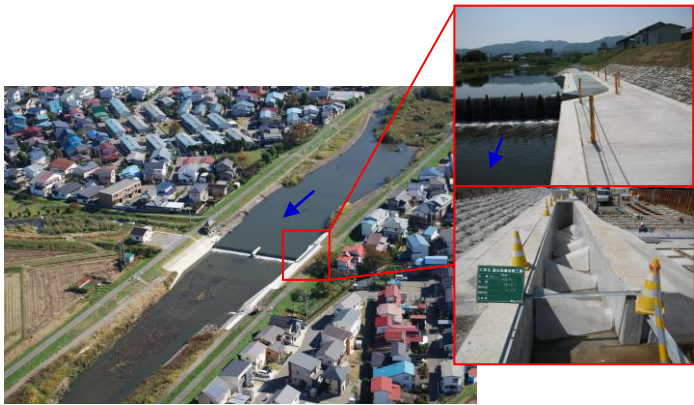
写真 3.71 湯川可動堰に設置された魚道
