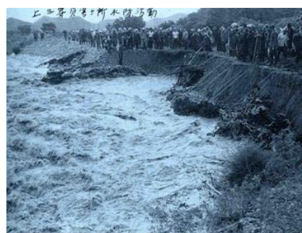
写真 3.38 昭和 33 年洪水 阿賀川右岸 河岸洗掘状況（会津若松市上三寄地区）
