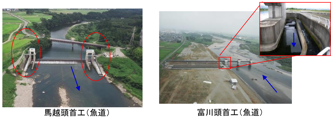
写真 3.70 阿賀川本川の頭首工に設置された魚道
