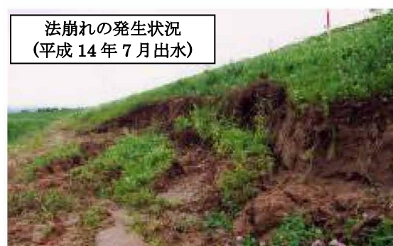
写真 3.32 既往洪水における堤防の被害
