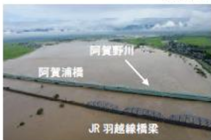
阿賀浦橋、JR 羽越線橋梁付近
