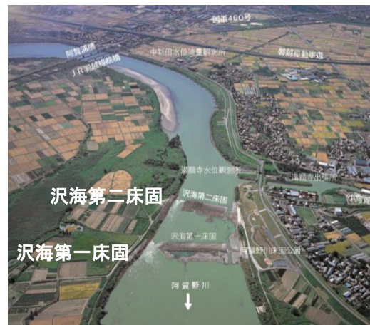
写真 3.20 沢海第一床固，第二床固
