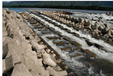
渡場床固に設置された魚道
