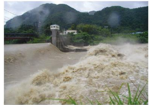
写真 3.6 馬越頭首工での出水状況
