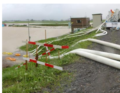
写真 3.56 排水ポンプ車及び稼動状況
