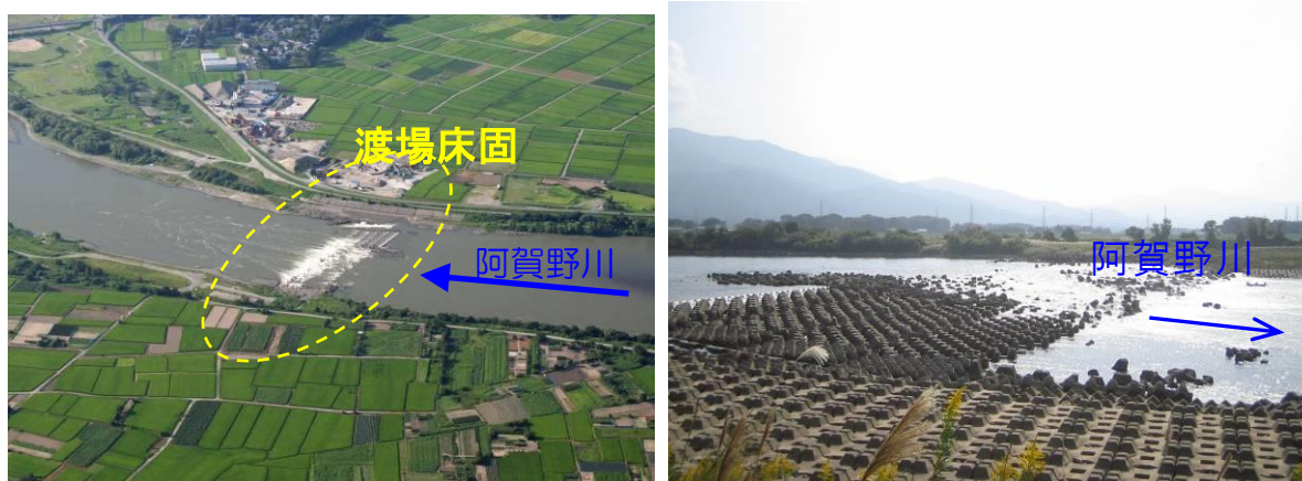
写真 3.30 現在の渡場床固
