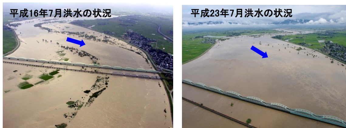
写真 3.42 中新田地区水衝部
