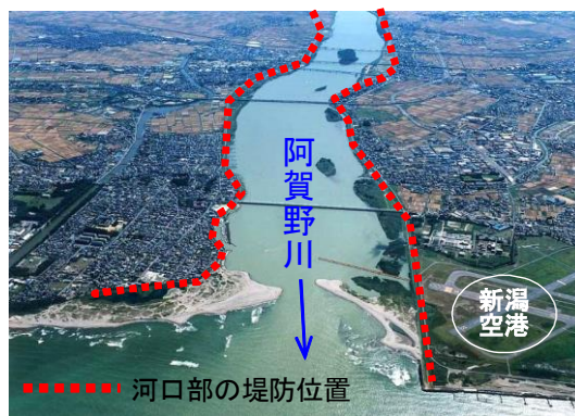
写真 3.34 河口部の堤防状況
