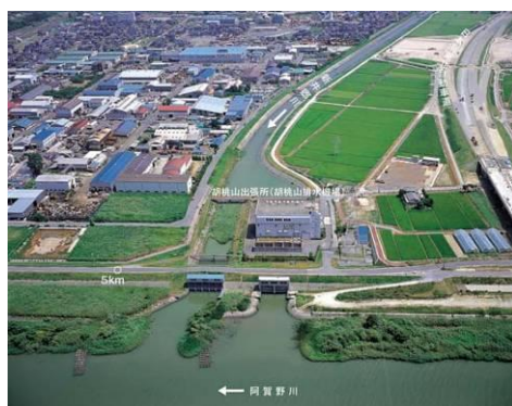
写真 3.25 現在の胡桃山排水機場
