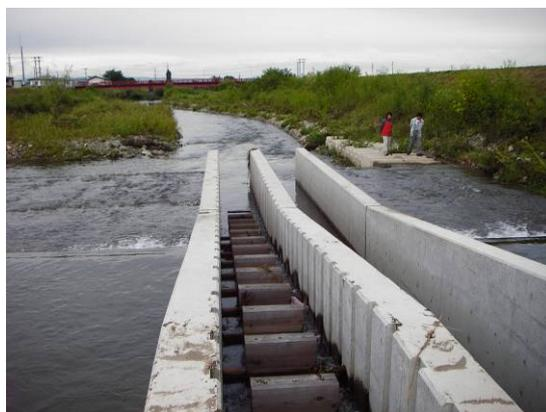
図 3.142 湯川洗堰に設置された魚道
