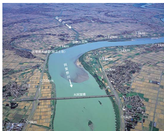
図 III-68 下流部の状況
