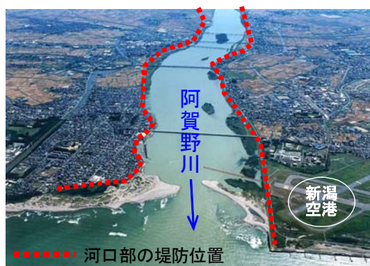
図 III-29 河口部の堤防状況
