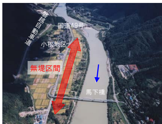
無堤区間の全景（阿賀野市小松地区）
