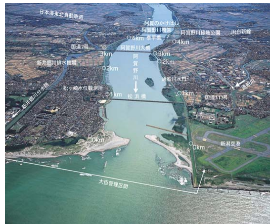
図 III-67 下流部の状況
