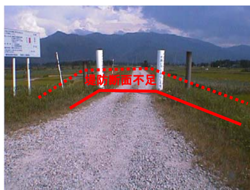
図 III-17 堤防幅が不足している区間 (五泉市論瀬)
