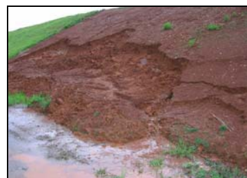
図 II-43 堤防の損傷
