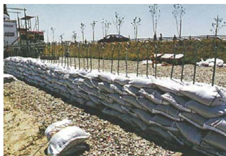
図 II-61 積み土のうエ
