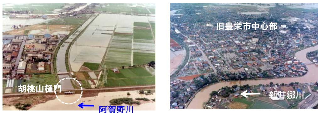
図 III-11 昭和 53 年 6 月 26 日洪水浸水状況
