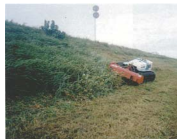
図 II-44 堤防除草の状況
