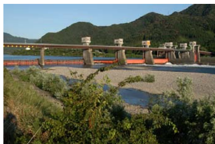
阿賀野川頭首工
