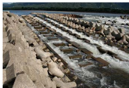
渡場床固めに設置された魚道
