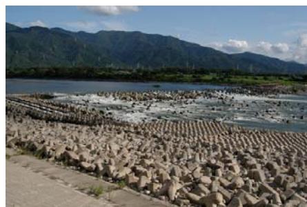
渡場床固めの全景
