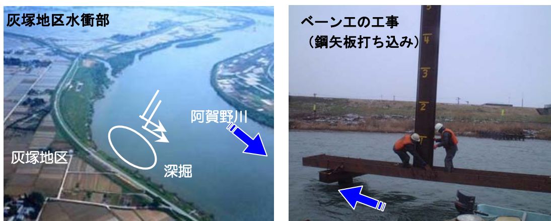
図 III-35 灰塚地区水衝部
