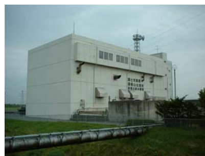
図 III-41 胡桃山排水機場（新潟市）
