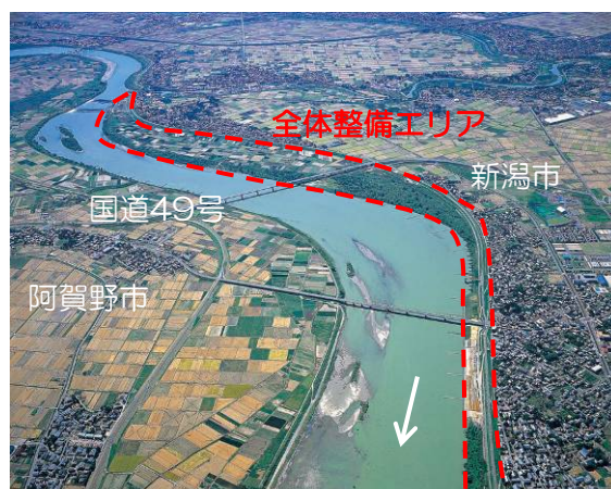
図 III-104 フラワーライン全体整備エリア
