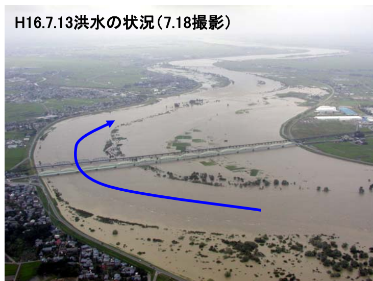
図 III-37 中新田水衝部
