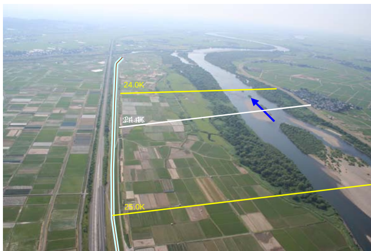
図 II-4 高山地区 弱小堤区間
