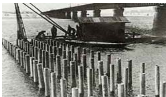
図 III-6 第二期改修計画の様子
