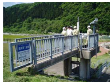
図 II-45 河川管理施設の点検
