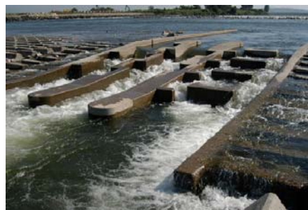
沢海第一床固に設置された魚道
