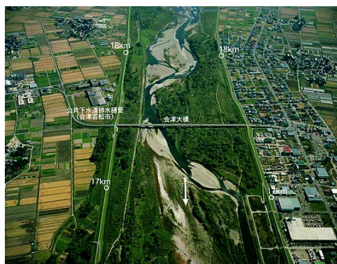
図 11-12 会津大橋付近(阿賀川 17k～18k) 【出典：阿賀川河川事務所資料】
