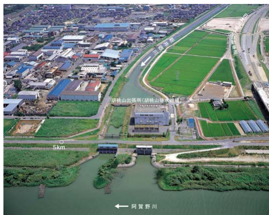
図 III-12 現在の胡桃山排水機場
