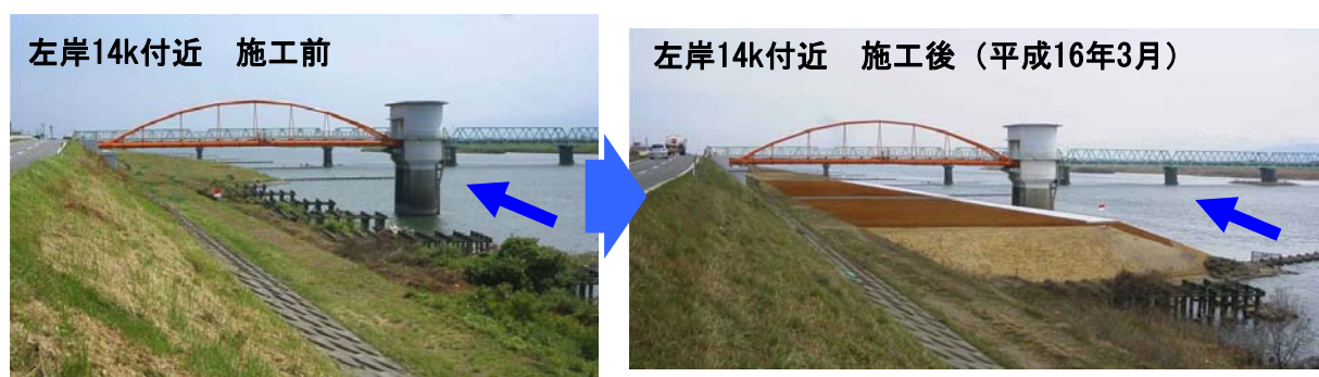
左岸 14k 付近低水護岸 施工前
