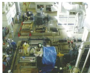
図 II-46 胡桃山排水機場におけるポンプ点検作業
