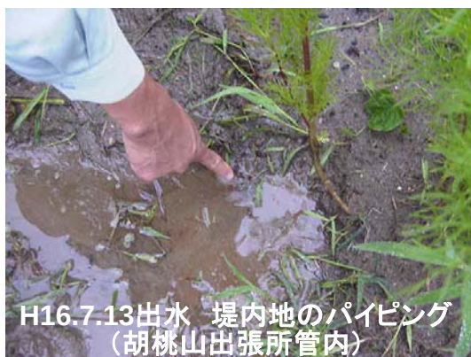
図 III-27 既往洪水における堤防の被害
