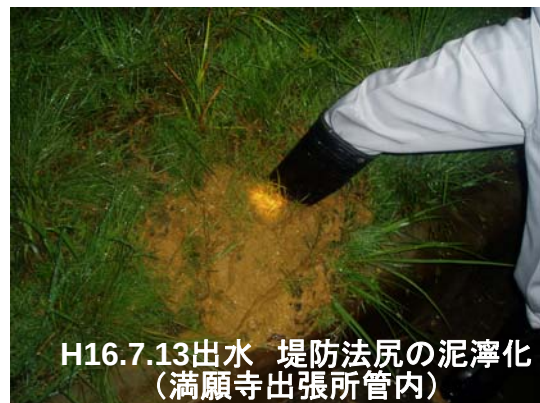
図 III-27 既往洪水における堤防の被害
