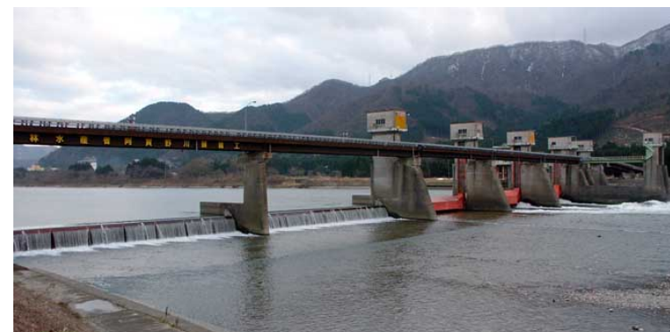
阿賀野川頭首工
