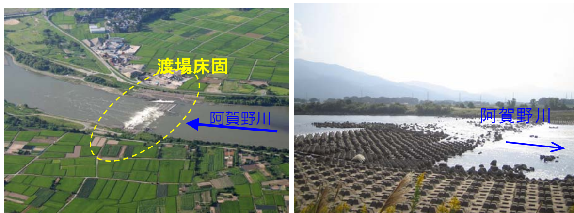
図 III-23 現在の渡場床固め
