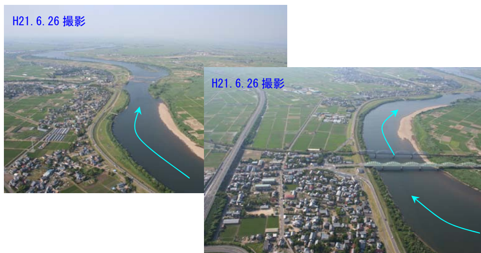
図 II-23 中新田地区水衝部の状況
