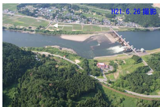
阿賀野川頭首工
