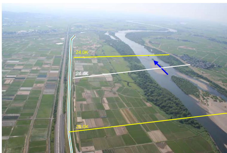
図 II-4 高山地区 弱小堤区間
