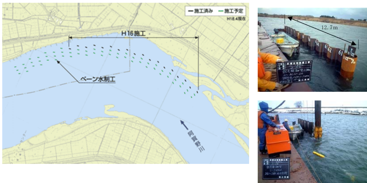
図 II-21 灰塚地区ベーン工設置状況
