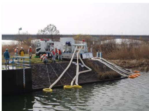
図 II-26 排水ポンプ車操作訓練
