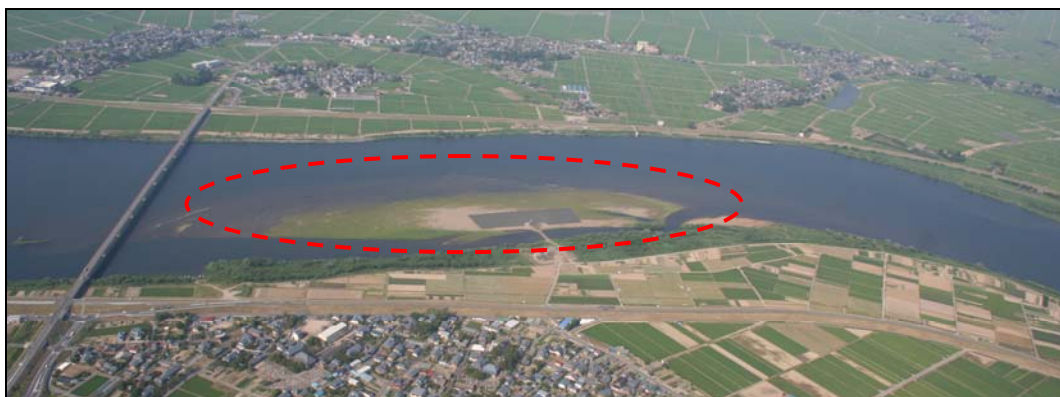
図 II-42 堆積土砂の除去
