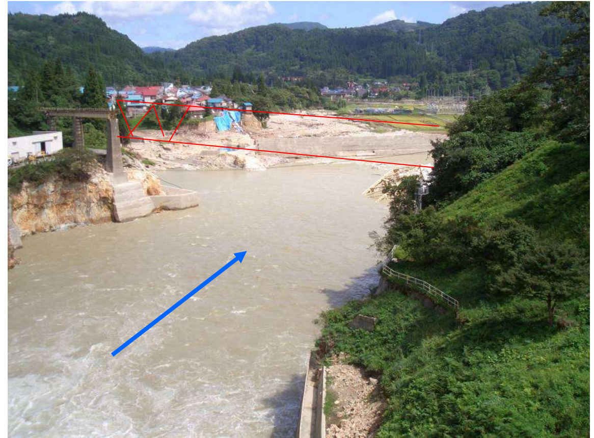
流失したJR橋梁
