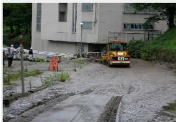
道路に堆積した大量の土砂 越川
