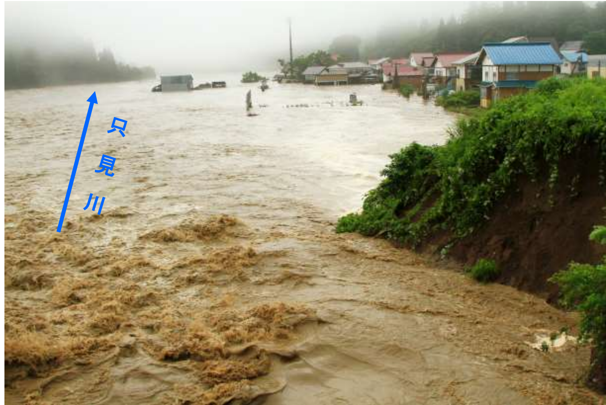
冠水した金山町西谷地区
