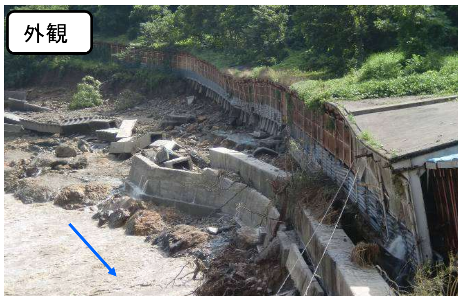
基礎部分が流失し傾いた滝スノーシェッド (国道252号 金山町滝沢地内)
