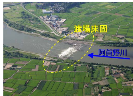
現在の渡場床固（29.4k付近）
