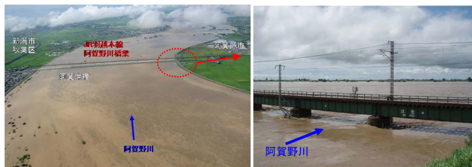
JR羽越本線阿賀野川橋梁右岸堤防の状況
