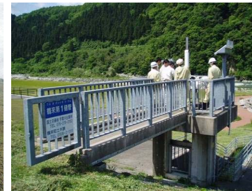
河川管理施設の点検
