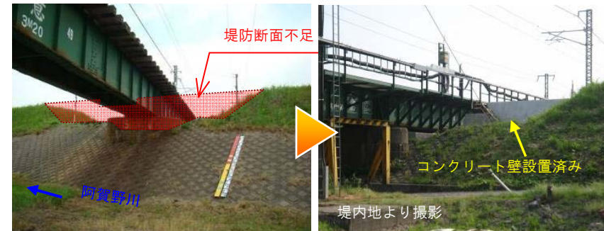
JR羽越本線阿賀野川橋梁右岸堤防の対策状況
