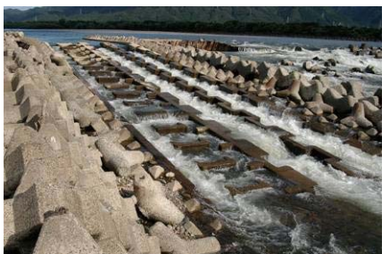
渡場床固の魚道
