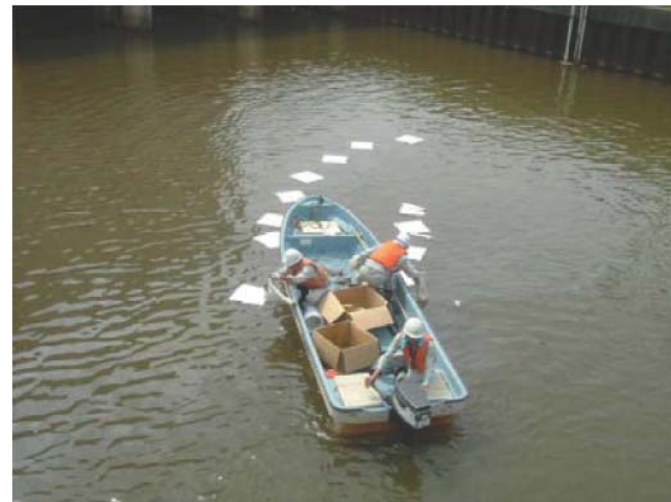
水質事故での油除去作業の様子
