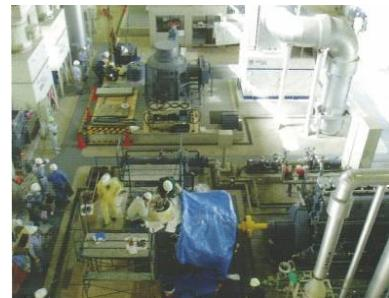
図 5.50 胡桃山排水機場におけるポンプ点検作業
