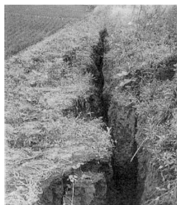
左岸7k 堤防裏法尻の亀裂（新潟市細山）
