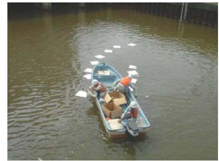
図 5.66 水質事故での油除去作業の様子
