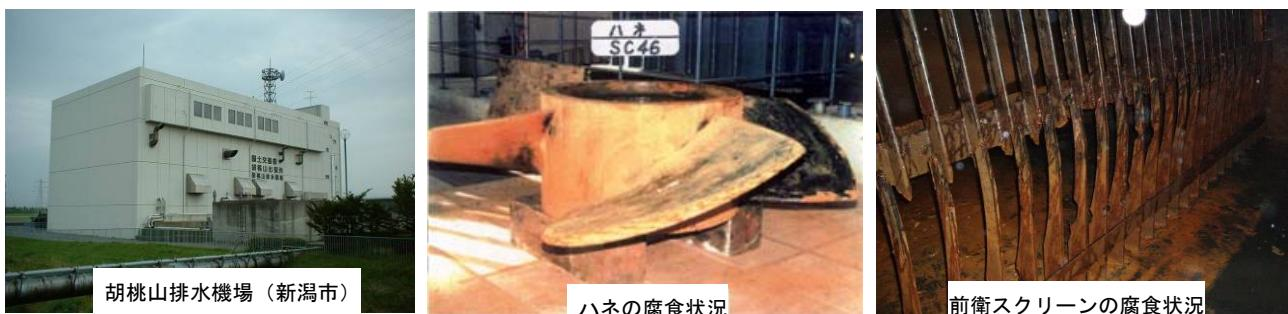
図 3.79 胡桃山排水機場設備の塩害による劣化
