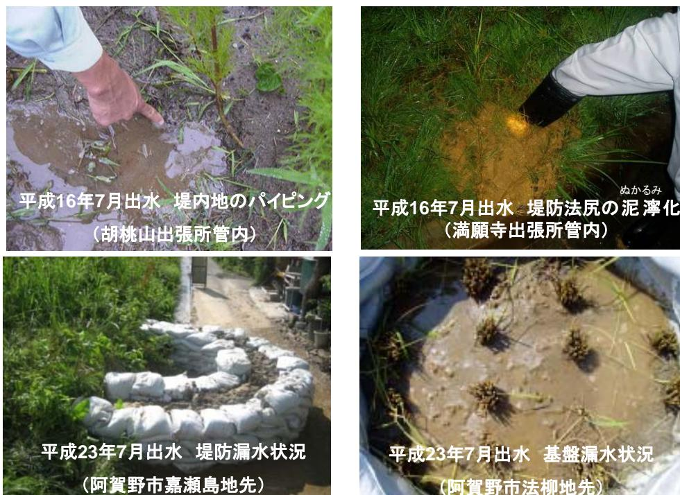
図 3.53 既往洪水における堤防の被害
