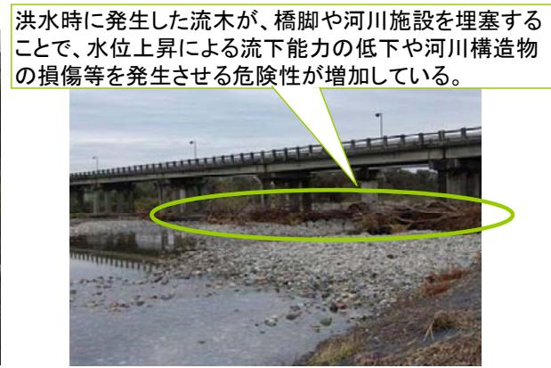
図 3.73 洪水に伴う流木の橋脚への堆積状況
