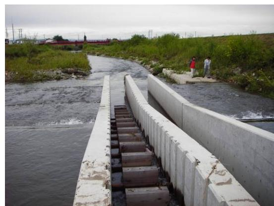
図 3.146 湯川洗堰に設置された魚道
