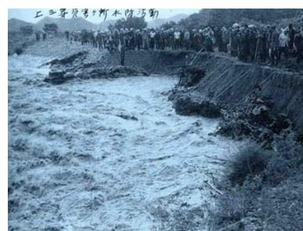
図 3.59 S33 洪水 阿賀川右岸 河岸洗掘状況（会津若松市上三寄地区）
