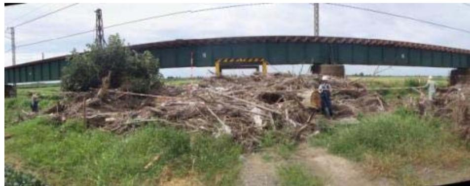
図 3.76 JR 羽越本線阿賀野川橋梁への流木の堆積状況（平成 23 年 7 月出水）
