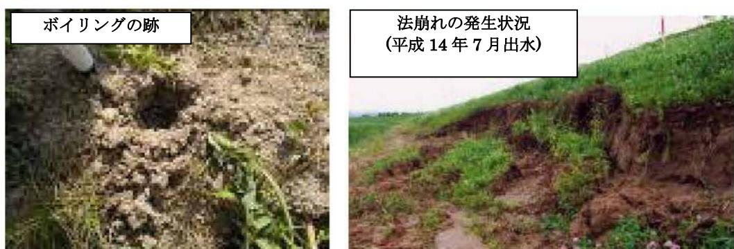
図 3.51 既往洪水における堤防の被害
