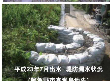
平成23年7月出水 堤防漏水状況
