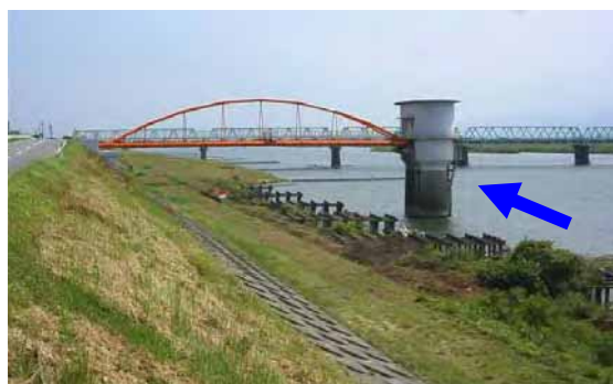
左岸14k付近低水護岸 施工前
