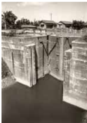
旧満願寺閘門（第一期改修）
