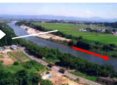
津尻地区掘削中（平成16年8月）
