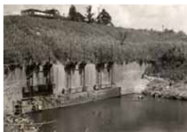
旧小阿賀樋門（第一期改修）
