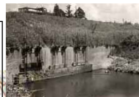
旧小阿賀樋門 （第一期改修）
