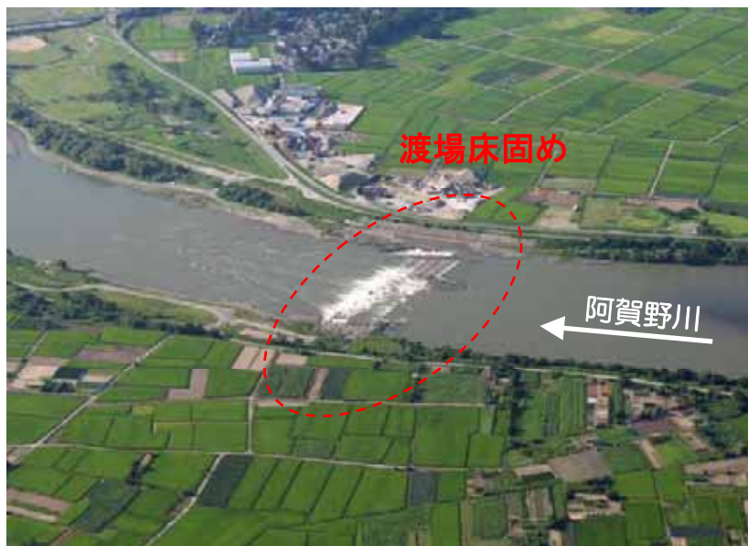
渡場床固め（撮影：平成20年8月）
