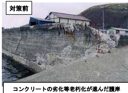
コンクリートの劣化等老朽化が進んだ護岸
