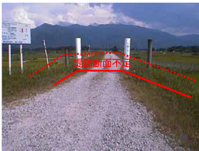
阿賀野川左岸笹堀地区
