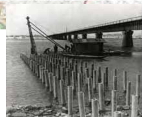
杭出水制と粗朶沈床
