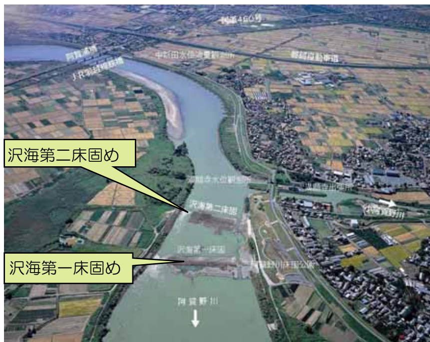
沢海第一床固め、第二床固め
