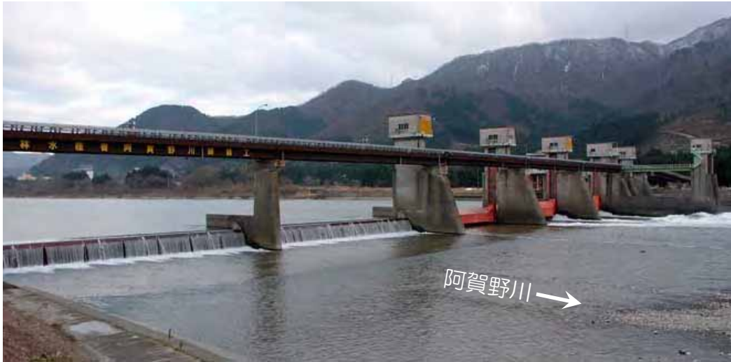
阿賀野川頭首工
