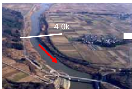
津尻地区掘削前（平成9年12月）
