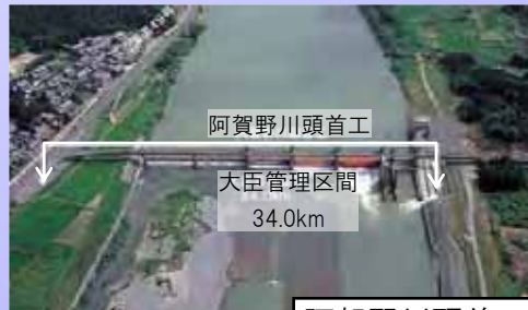
阿賀野川頭首工
