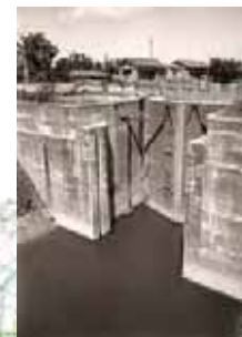
旧満願寺閘門 （第一期改修）
