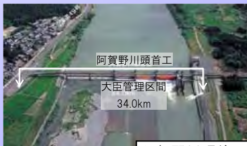
阿賀野川頭首工
