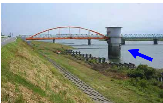
左岸14k付近低水護岸 施工前
