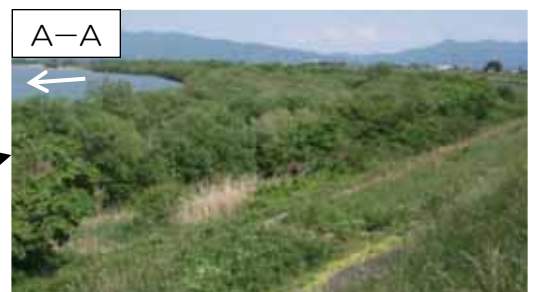
阿賀浦橋周辺より上流を望む 高水敷一面樹木が密生
