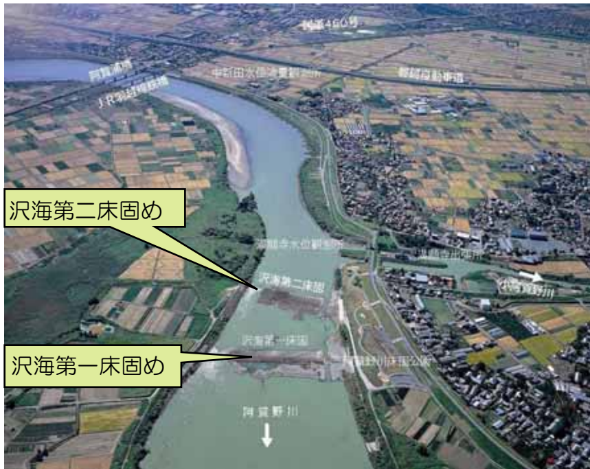
沢海第一床固め、第二床固め
