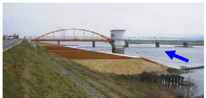
左岸14k付近低水護岸 施工後（平成16年3月）
