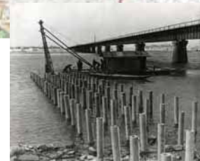
杭出水制と粗朶沈床
