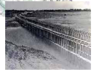
沢海高水敷床固め
