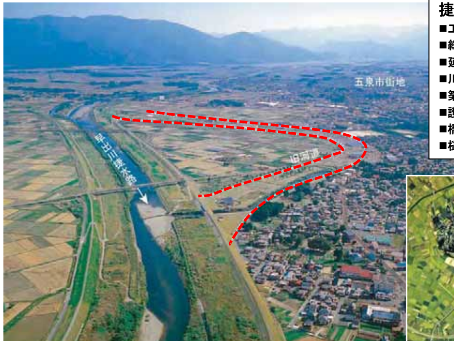
早出川捷水路
