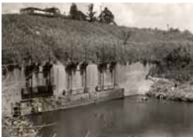
旧小阿賀樋門（第一期改修）
