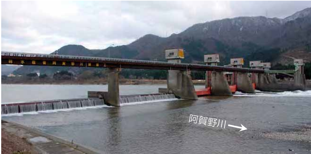
阿賀野川頭首工
