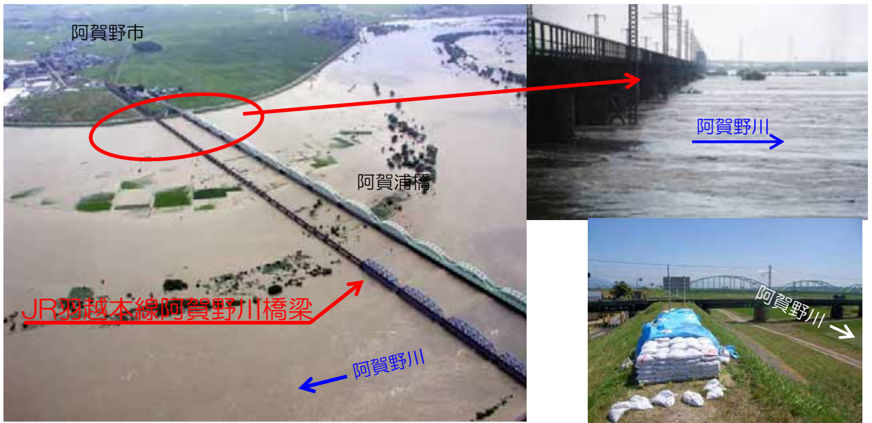
平成16年7月13日洪水時のJR羽越本線阿賀野川橋梁付近の状況
