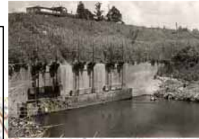
旧小阿賀樋門 （第一期改修）
