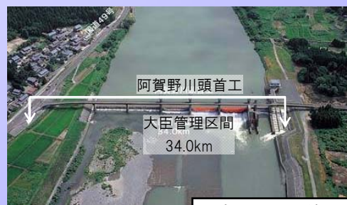
阿賀野川頭首工
