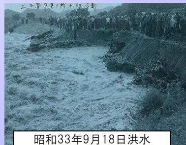
昭和33年9月18日洪水 阿賀川右岸(会津若松市)
