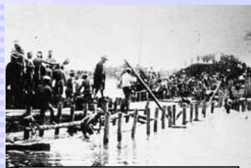
大正2年8月27日洪水 木津の破堤箇所を復旧する様子(新潟市)
