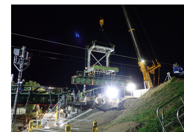
② 既設橋桁の撤去
