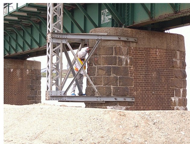
レンガ構造の橋脚（羽越本線阿賀野川橋梁）
