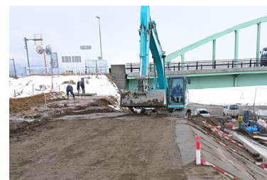
07.特殊堤設置、堤防拡幅、護岸設置
