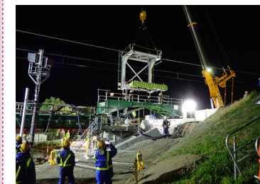
④ 新橋桁設置
