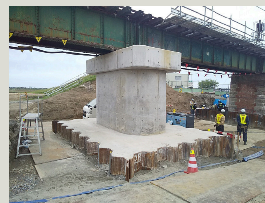
橋脚補強（RC巻き立て構造）状況
