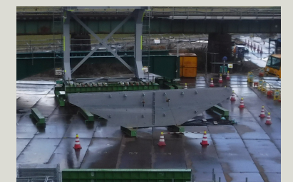
設置前の鋼製特殊堤型枠
