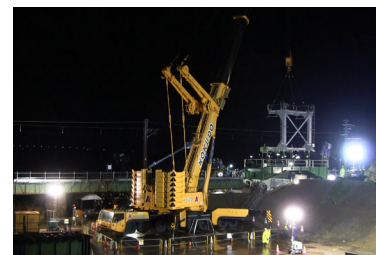
06.橋桁架替え・特殊堤型枠設置
