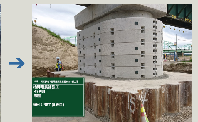
橋脚への鞘管の設置状況
