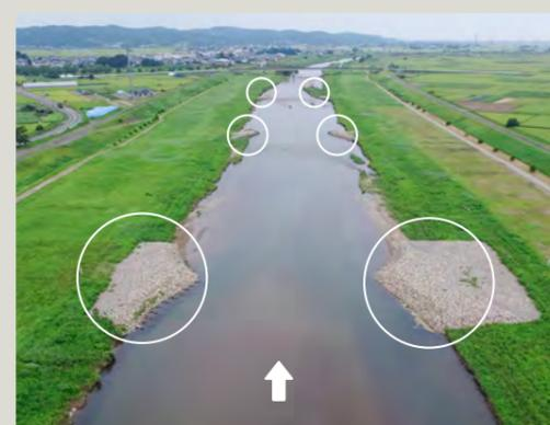
新潟大学との共同研究により、早出川の捷水路区間へ対称に水制を設置し、河岸や川幅に変化を持たせる拡縮流路工を実施しました。縦断方向の断面幅に変化を与えることで、交互砂州のような単調な河床形状への収束を回避します。この取り組みは全国初の事例であり、事業効果も評価され、令和3年度全建賞を受賞しました。
