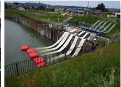
緊急排水ポンプ投入
