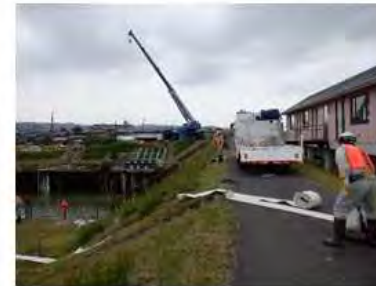
手前排水ポンプ車 奥緊急排水ポンプ設営
