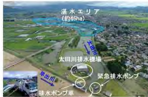
新潟・福島豪雨時の状況(H23.7)
