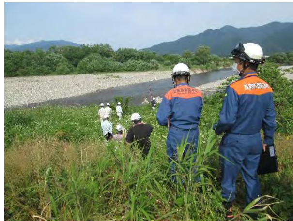
早出川洗堀場所の点検 (川瀬・五十嵐新田地内)
