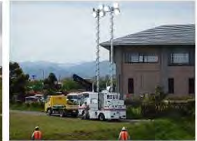
照明車設営訓練
