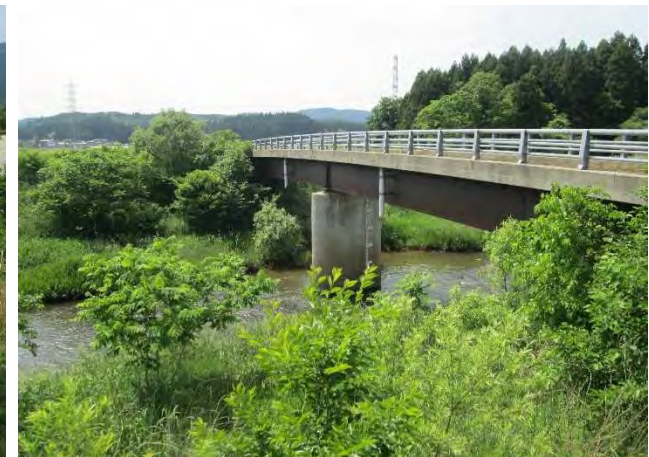
能代川千原水位観測所付近 (千原地内)
