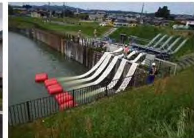
緊急排水ポンプ投入
