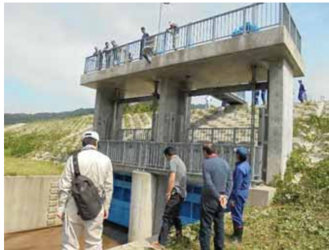
樋門付近の堆積状況を確認
