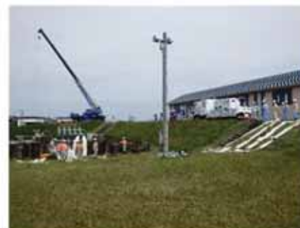
排水ポンプ車設営訓練
