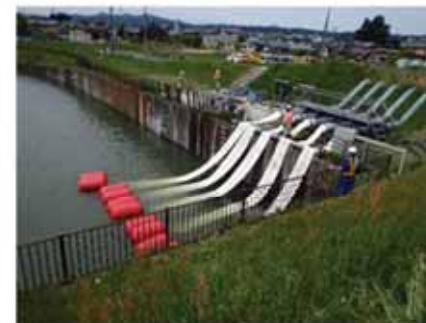
緊急排水ポンプ投入
