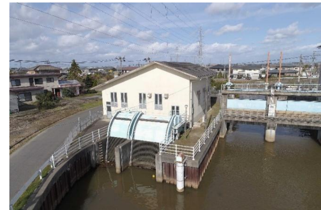
長浦岡方排水機場
