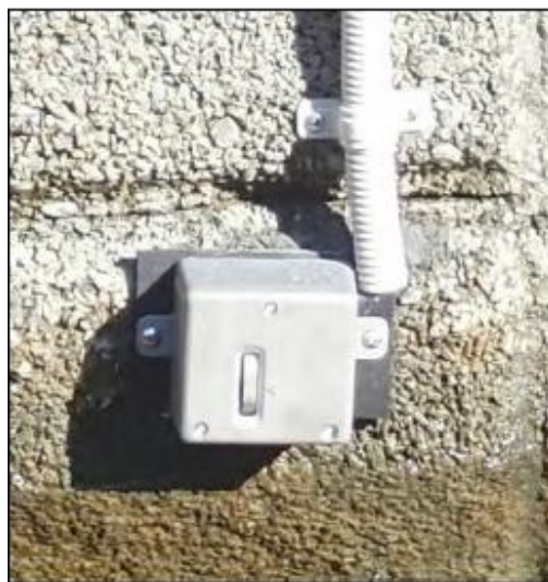
浸水センサと通信器の拡大写真
