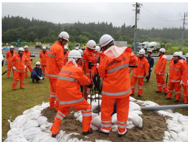
阿賀町消防団による釜段工法訓練および点検の様子
