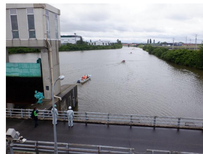
排水機場から福島潟へ遡上
