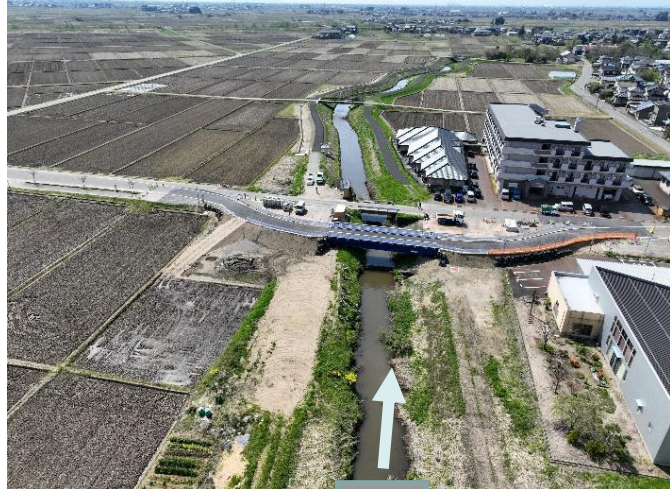
駒林川の河道拡幅及び築堤・護岸整備
