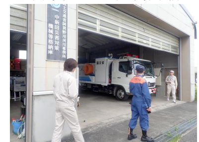
中新田災害対策機械等格納庫
