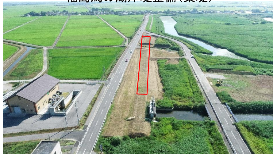
福島潟の湖岸堤整備(築堤)
