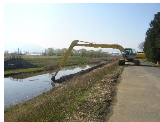
阿賀野川水系太田川河床掘削（工事状況）
