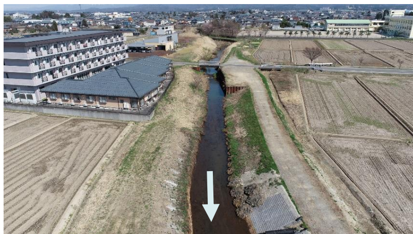
駒林川の河道拡幅及び築堤・護岸整備
