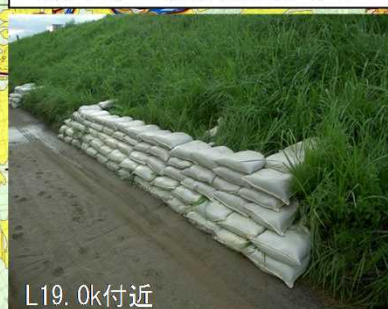
のりじり ろうすい <月の輪工(法尻漏水防止)>
