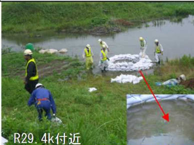
かまだん のりじり ろうすい <釜段工法(法尻漏水防止)>
