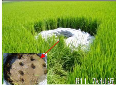
かまだん きばんろうすい <釜段工法(基盤漏水防止)>
