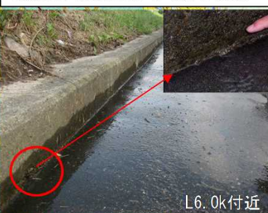
のりさき ろうすい 堤防背面法先部からの漏水状況
