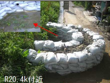
のりじり ろうすい <月の輪工(法尻漏水防止)>
