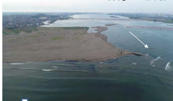
写真①-1 着手前
