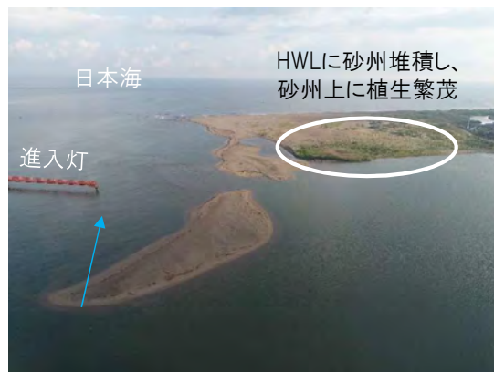
H31.4撮影 河道中央～右岸砂州方向
