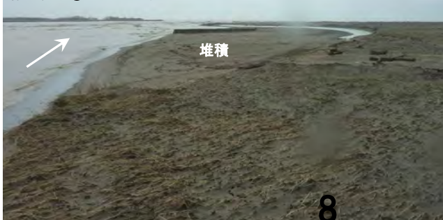
掘削箇所①-3 出水後
