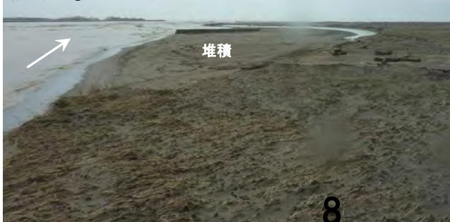
掘削箇所①-3 出水後
