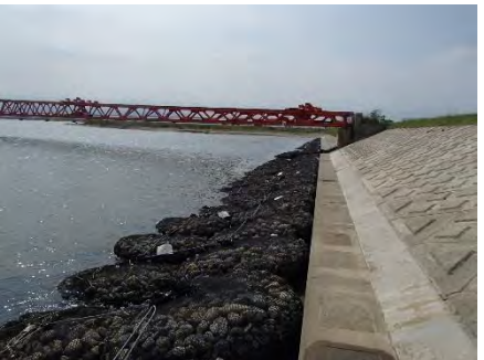
H30.8末 根固め部応急対策 袋詰玉石263袋設置
