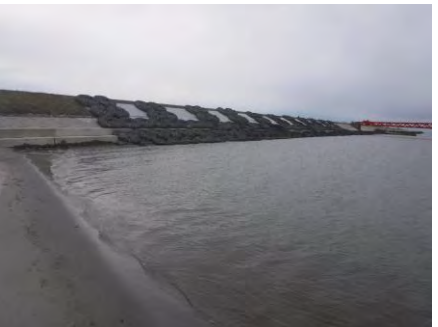
H30.12末 法面部応急対策 袋詰玉石109袋設置
