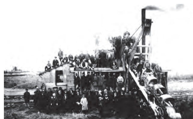
第一期改修時の掘削作業に活躍したエキスカベーター
