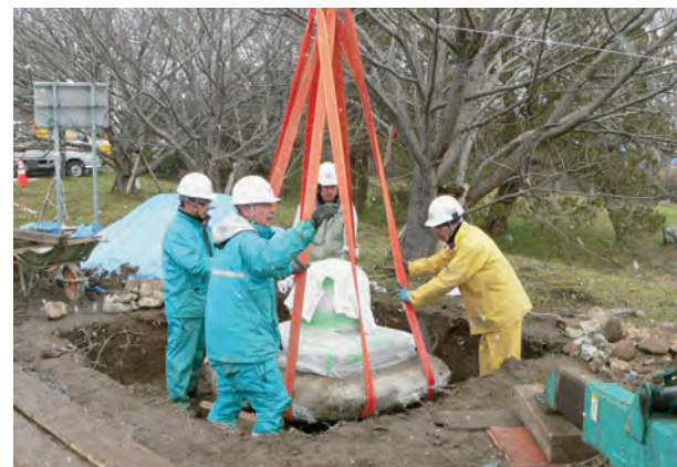
①基礎を崩さないよう丁寧に吊り上げ
