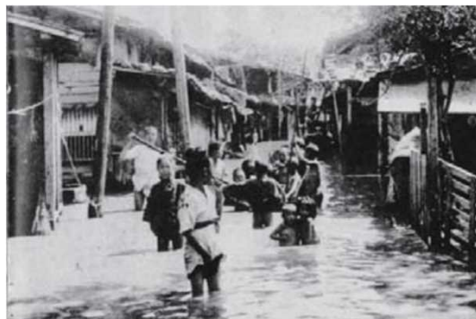
木津切れによる被害の様子(1913年)
