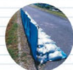
川側から見た完成状態
