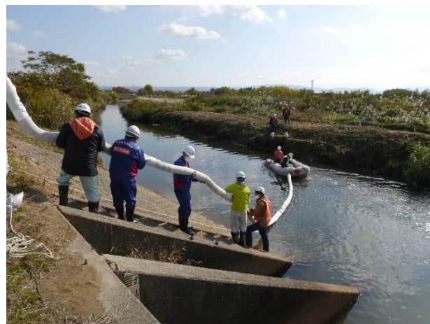
オイルフェンスの展張
