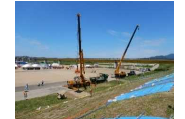
新潟県、国土交通省、北陸地方防災エキスパート及び災害時協定業者による応急復旧工（大型土のう工・ブロック投入工）
