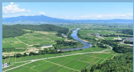
1921年に捷水路の開削と現川の堀削・拡幅・整正工事開始『泡の巻橋&袋原』
