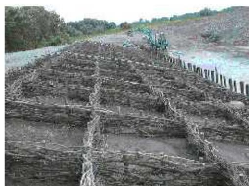
写真-7.3 自然河岸をつくり出す水制工
