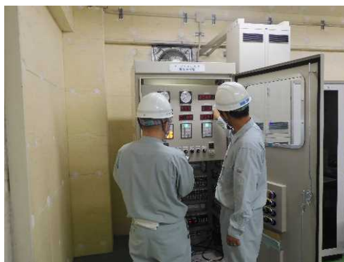
操作盤の点検 (湯川可動堰)
