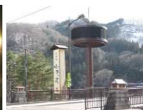
電光表示板 (阿賀川・ 芦ノ牧橋)
