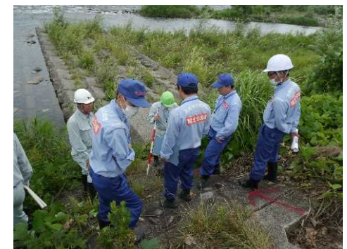
ブロック中詰材流出状況の確認
