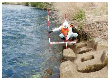
堤防等の出水期前点検
