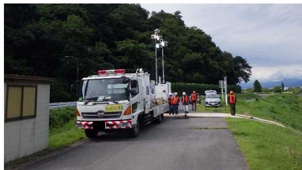
排水ポンプ設置
