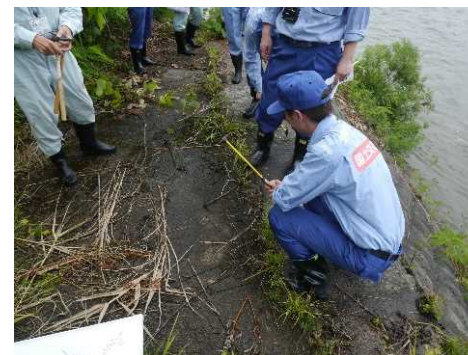
低水護岸天端平張の空洞点検
