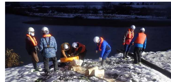
排水ポンプ設置
