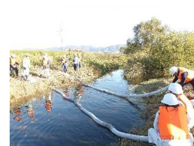
オイルフェンス展張完了
