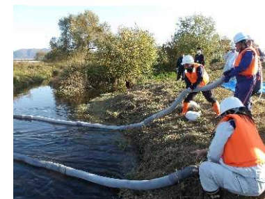
オイルフェンスの展張作業
