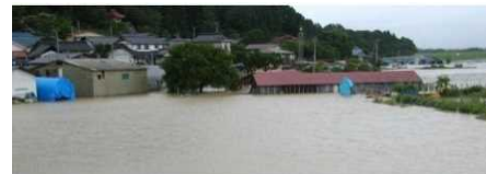
田畑・道路冠水被害状況 (喜多方市山崎(5k)地先)
