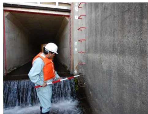
点検足場等付属施設の点検 (大石排水樋管)
