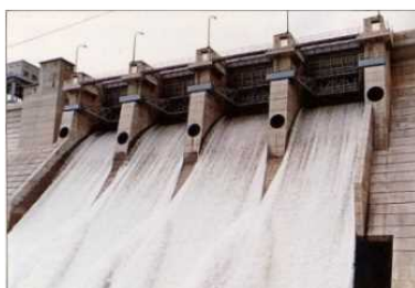
クレストゲートからの放流 (試験湛水時)
