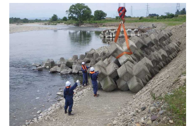
河岸侵食応急対応 (コンクリート異形ブロック設置)
