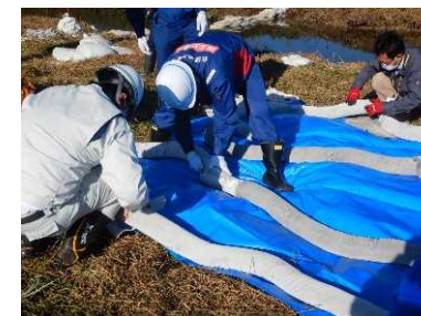
オイルフェンス接続作業
