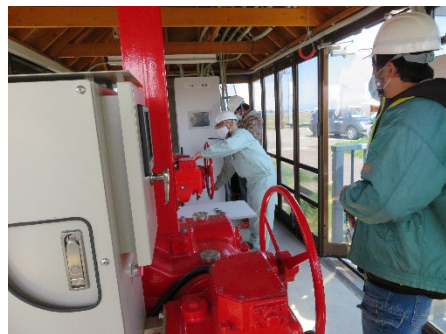
樋門ゲートスピンドルの点検 (湯川樋門)
