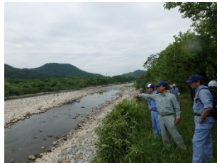
職員による堤防等点検
