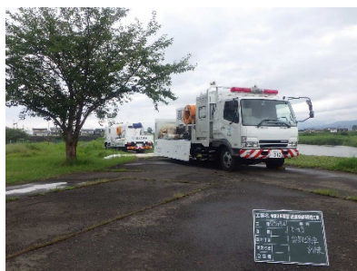
排水ポンプ車設営
