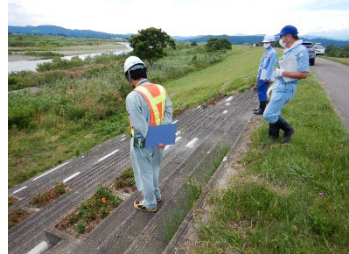
喜多方市親水護岸の点検
