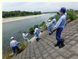
職員による堤防点検
