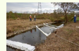
関係機関で水質事故対応訓練 （オイルフェンス設置）
