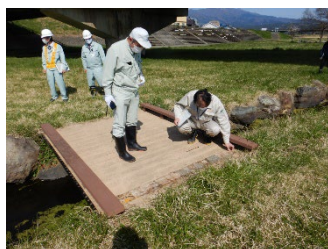
日橋川緑地公園の点検
