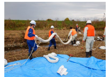
オイルフェンスの展張作業
