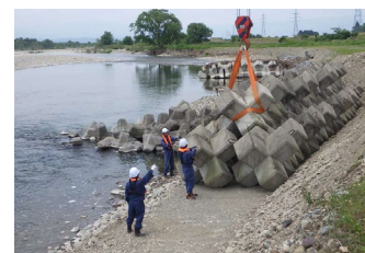
河岸侵食応急対応 (コンクリート異形ブロック設置)
