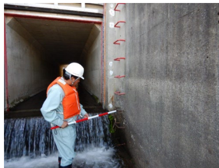
点検足場等附属施設の点検 (大石排水樋管)
