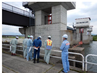
富川頭首工周辺の点検
