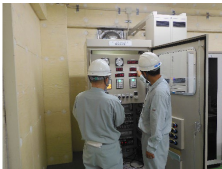
操作盤の点検 (湯川可動堰)
