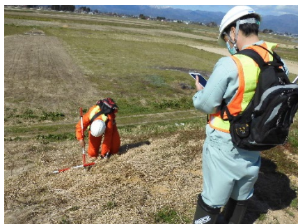
堤防法面の水みち
