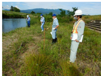
湯川村工業団地公園付近の親水護岸点検
