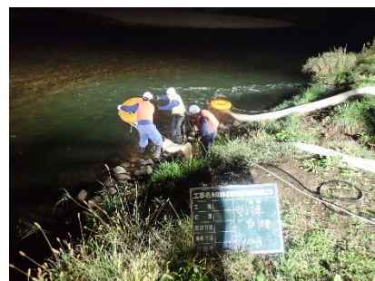
排水ポンプ設置（夜間）
