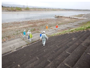
飯寺護岸の点検
