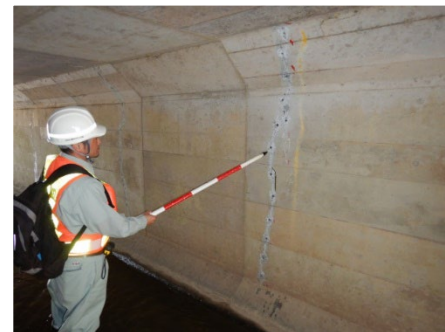
排水樋管等の函体内部の点検 (宇内第一排水樋管)
