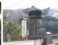
電光表示板 (阿賀川・ 芦ノ牧橋)
