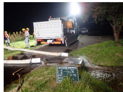
排水操作（夜間）
