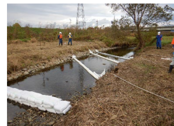
オイルフェンス展張完了
