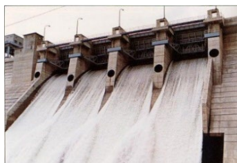
クリストゲートからの放流 (試験湛水時)
