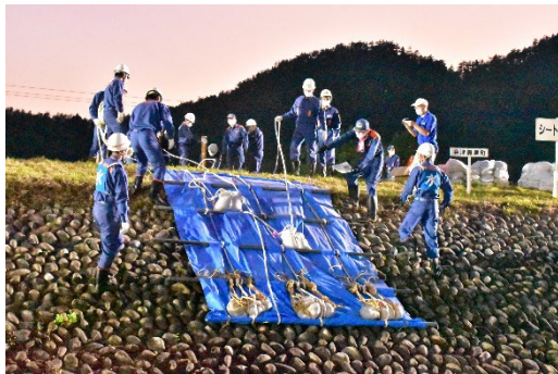
シート張り工
