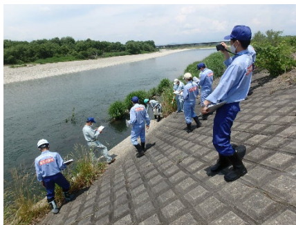
低水護岸矢板基礎の傾倒
