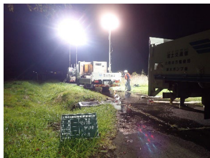
照明車設営（夜間）
