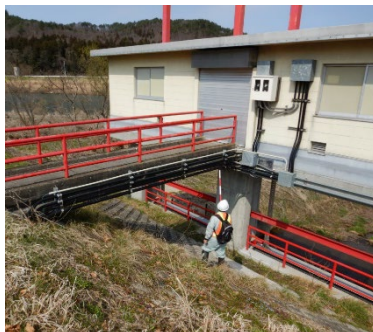
排水樋管等の門柱、翼壁、管理橋等の外観点検 (宇内第一排水樋管)
