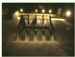
コンバットポートからの放流 （平成27年9月10日）
