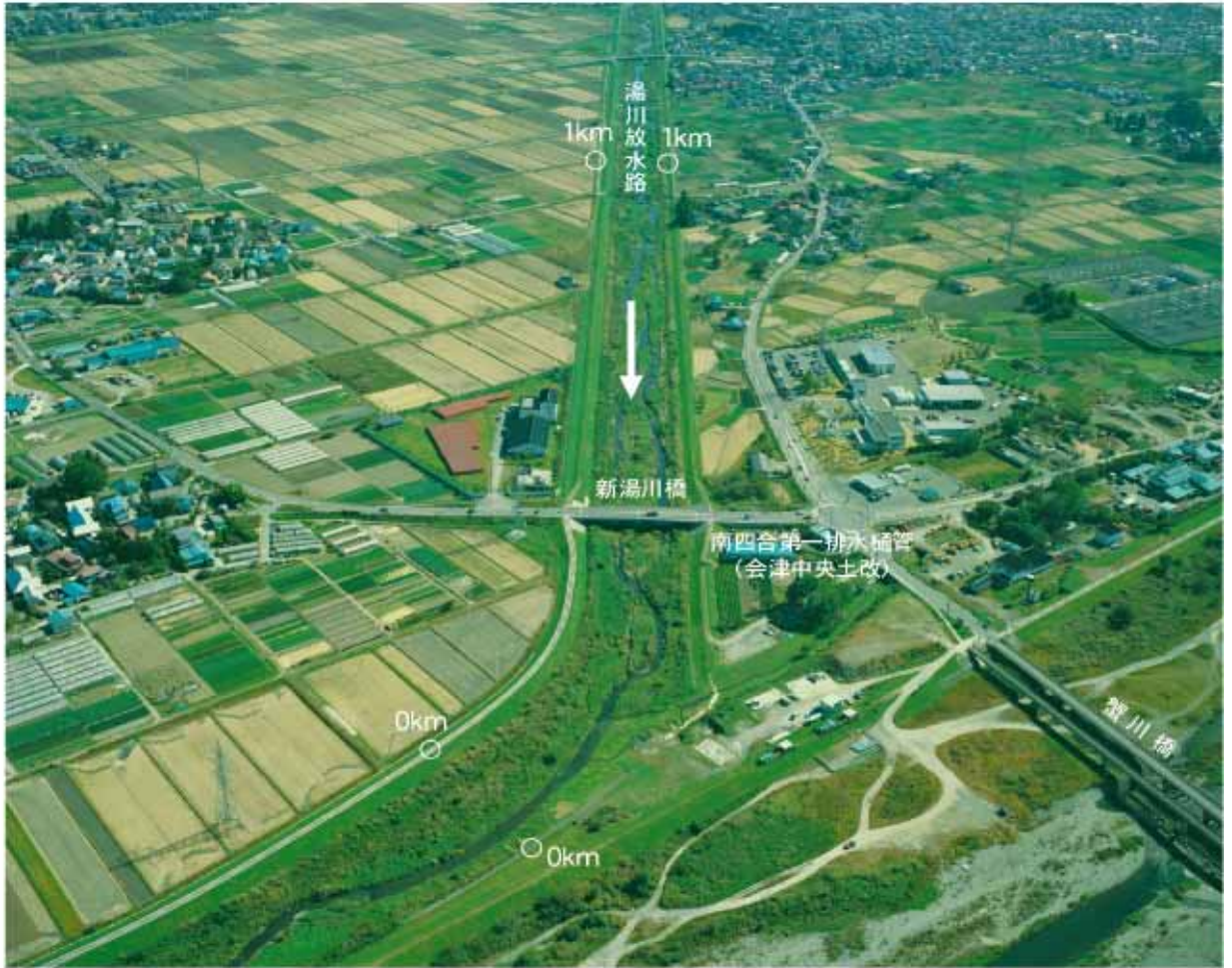
45.湯川放水路 距離標 0km~1km
