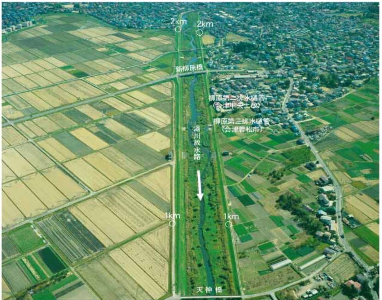
46.湯川放水路 距離標 1km~2km
