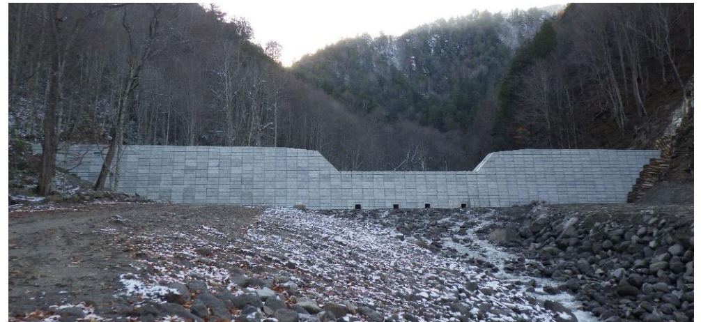
施工後(R7年度完成)
