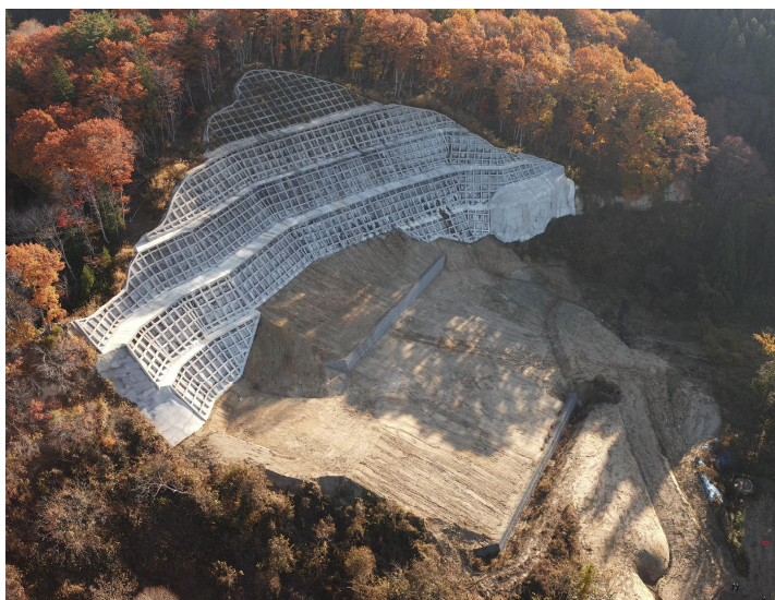
地すべり対策工 R7施工中 藤沢(喜多方市)
