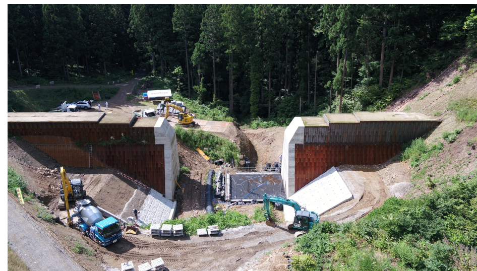
砂防堰堤工 R7施工中 熱塩沢(喜多方市)
