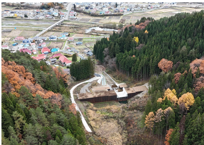
砂防堰堤工 R6完了 宮ノ沢(南会津町)
