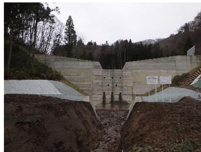
砂防堰堤工 R5完了 西田面沢(会津若松市)
