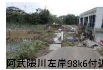
阿武隈川左岸98k6付近
