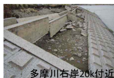
多摩川右岸20k付近
