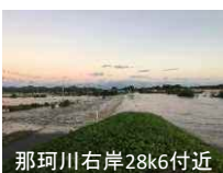
那珂川右岸28k6付近
