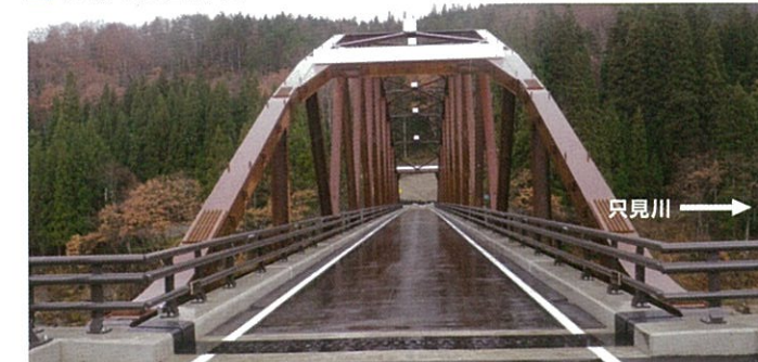
■ 完成した西部橋
