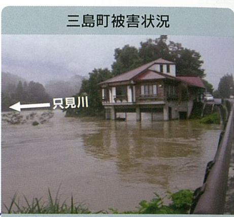
▲三島町温泉施設の浸水状況
