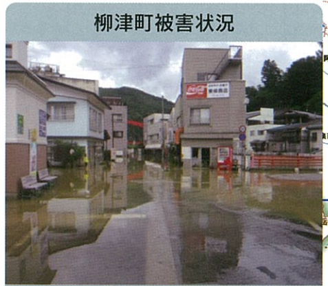
▲柳津温泉街の浸水状況
