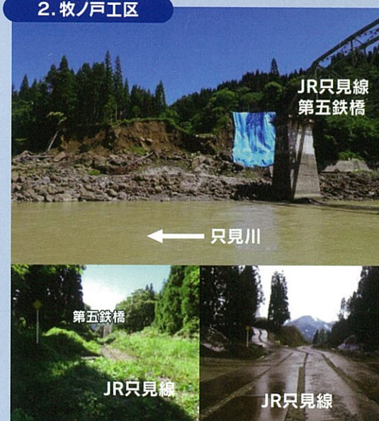
▲線路上を利用した仮設道路 ※工事完了後、復旧済
