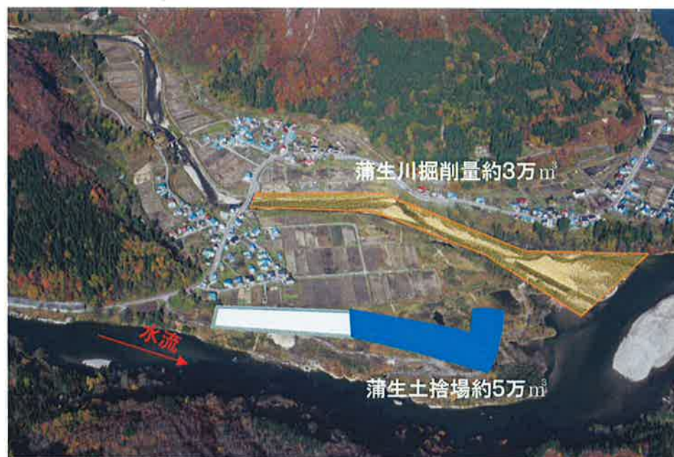
蒲生川合流部付近
