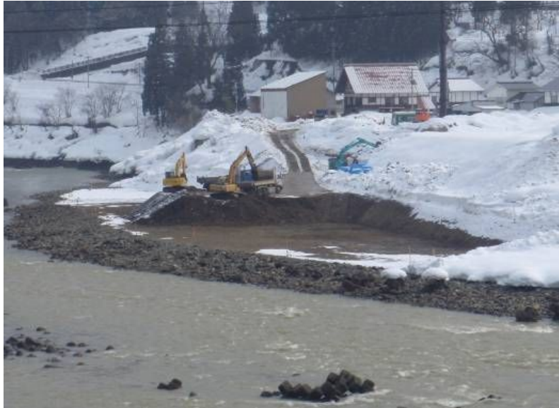
西谷地区土砂排除状況(平成23年度)
