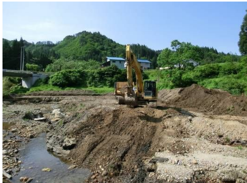
大川入沢河口土砂排除状況(平成24年度)
