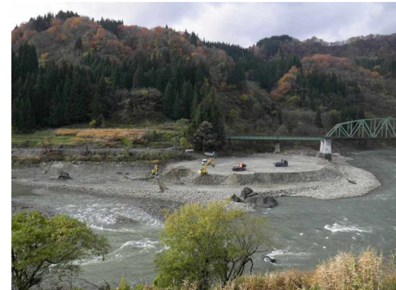
本名地区下流土砂排除状況(平成24年度)
