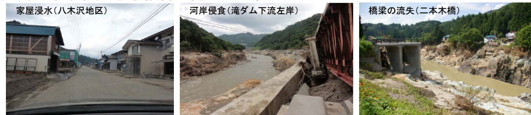
図1. 只見川筋における浸水・河岸侵食・橋梁流失被害
