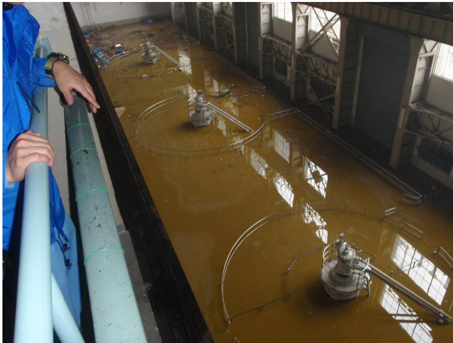
④ 上田発電所 発電機浸水状況 (7/30)
