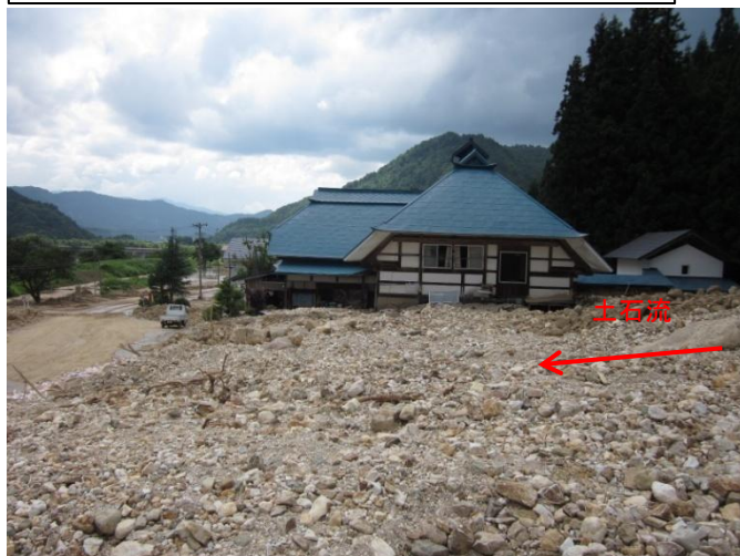
南会津郡只見町熊倉地区(宮ノ前沢)
