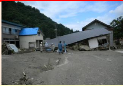
国道252号 (只見町八木沢地内)
