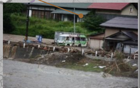
伊南川・国道401号 (南会津町内川地内)
