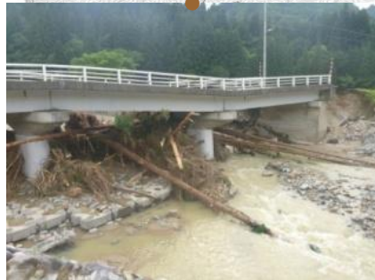
国道289号 花立橋 (只見町楢戸地内)
