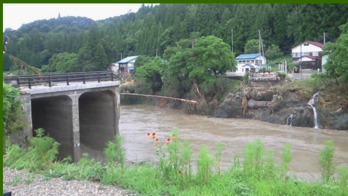
国道252号（金山町横田地内・二本木橋）
