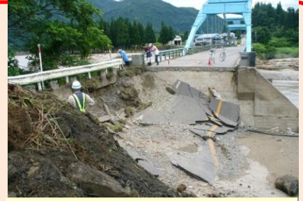
国道252号 蒲生橋 (只見町蒲生地内)
