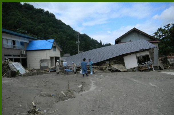
国道252号（只見町八木沢地内）
