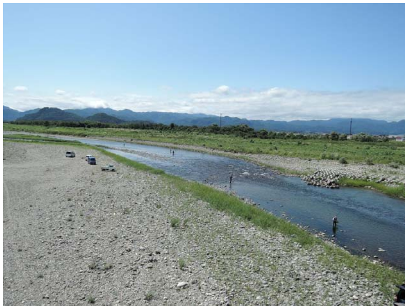
高田橋上流 H27.8.28
