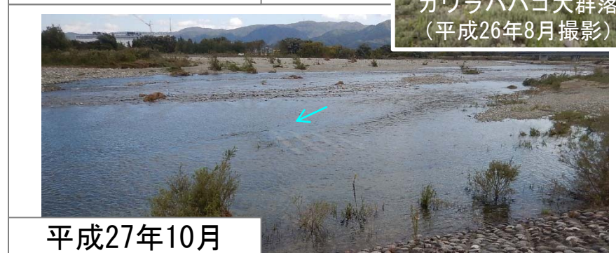
工事後の定点写真
